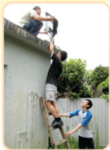
男生拆卸屋頂大光燈
